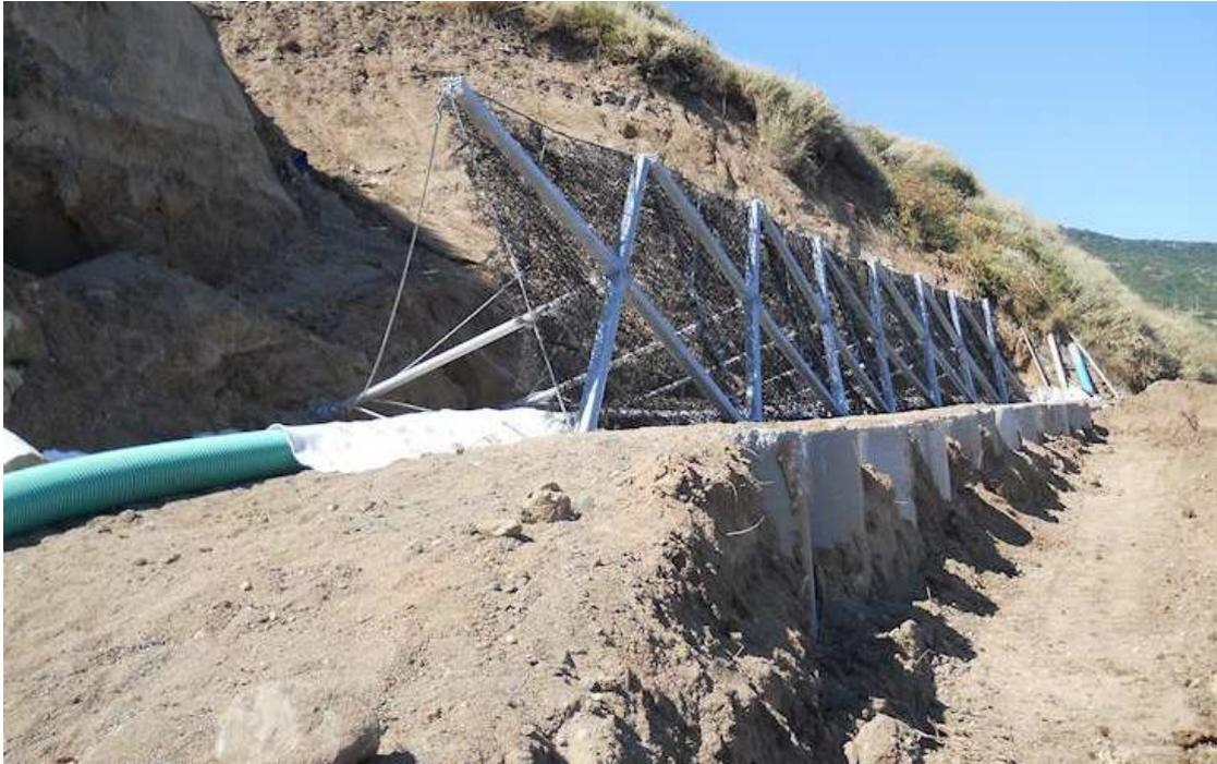
Una volta montata in sito la struttura viene predisposta per essere fissata al suolo con barre di idonea dimensione, inserite ad adeguata profondità nel terreno coerente. Di seguito si riportano le caratteristiche dei paramassi ad ombrello, l'elemento individuato è quello relativo alla spinta di progetto di 300KN.
